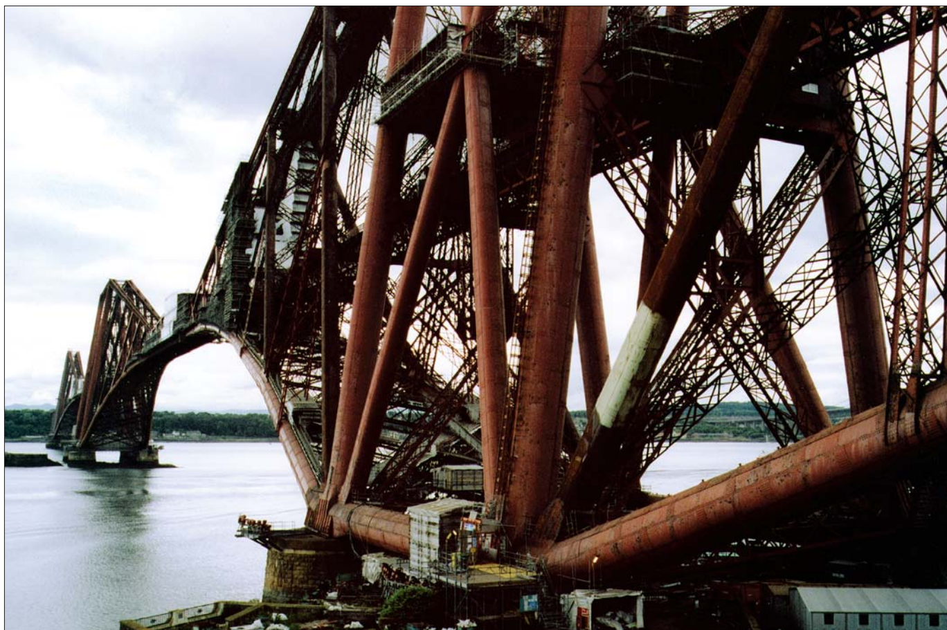
5. kép: A skóciai Forth vasúti híd 100 m magas gigantikus szerkezete (1890)
