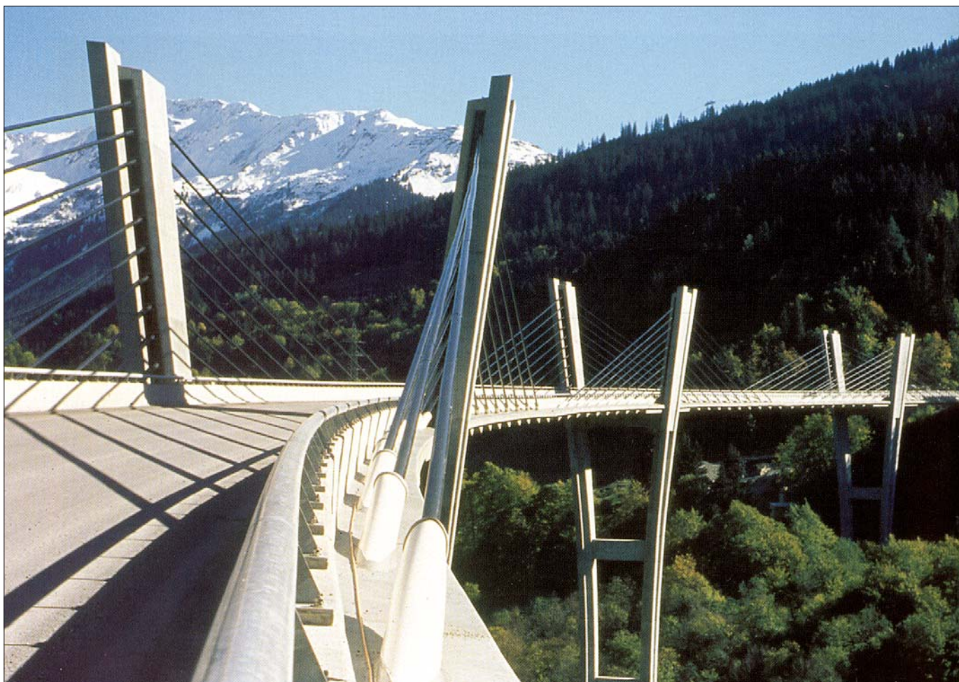
A táj és a híd egymásratalálása – Svájc, Sunnibergbrücke
