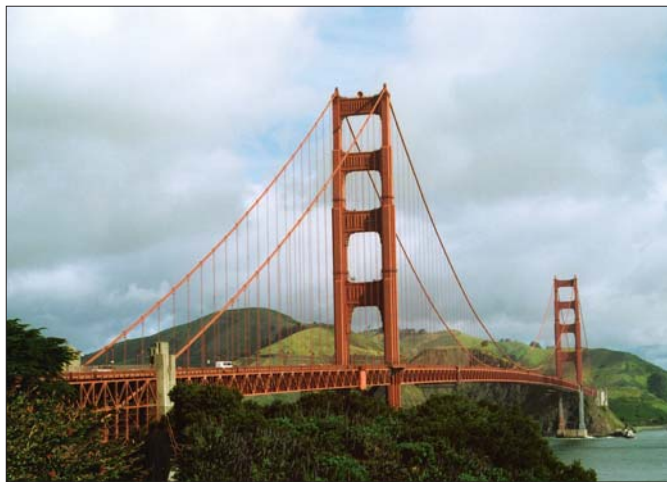
1. kép: A San Franciscó-i Golden Gate híd (1937)
