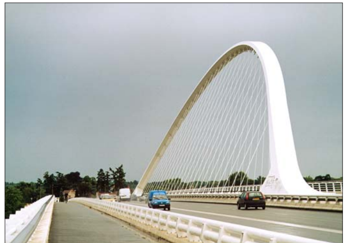
4. kép: Az ív kifelé dől, a pályaszerkezet konzolosan helyezkedik el
