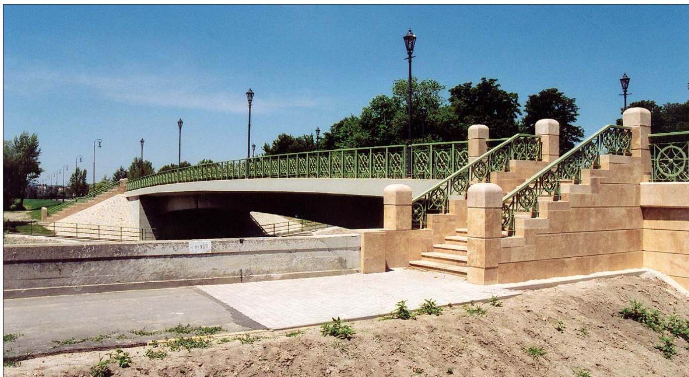
Kis szerkezeti magasság jellemzi hídjaink túlnyomó többségét – az esztergomi Árok utcai híd
