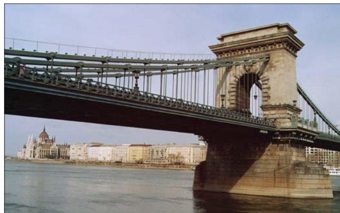
18. kép: Az átépítés utáni híd markánsabb acélszerkezete jobban harmonizál a robusztus kőkapuzattal
