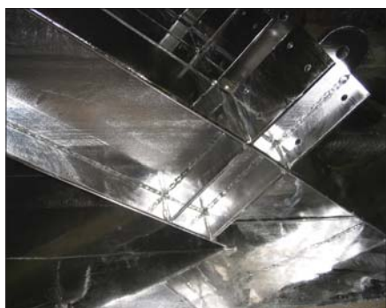
1. kép: Tűzhorganyzás (Fotó: Antal Árpád)
