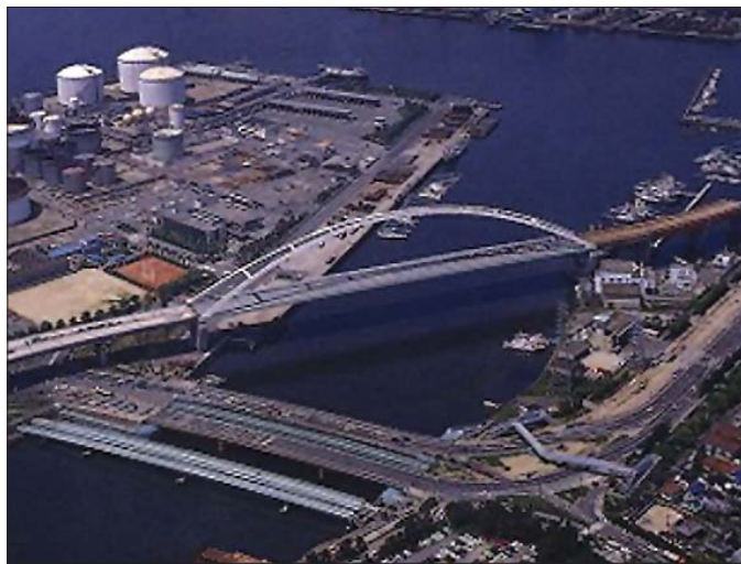
2. kép: A Shin-Hamadera híd
