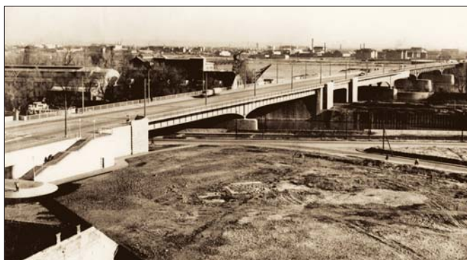
6. kép: Az Árpád híd az első kiépítési fázisban Budáról szemlélve. Az előtérben a háború előtt teljes szélességgel, négy nyílásban megépült, négy főtartós, a sziget felé a háború utáni, csupán két főtartóval folytatott szerkezet látható (1950)
