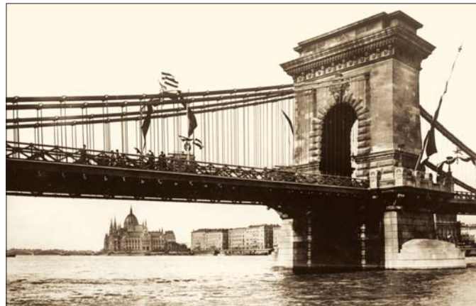
17. kép: Az eredeti híd a rövid láncokkal, a sűrűn elhelyezkedő függesztő rudakkal és a karcsú, részben fából épült pályaszerkezettel
