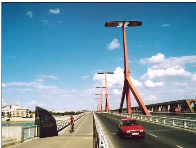
50. kép: A híd 2x2 nyomsávú (a középére tervezett villamosvágányokat eddig nem helyezték el), a befolyási oldalon gyalogosjárda és kerékpárút van
