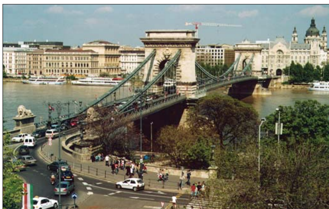
20. kép: A Lánchíd 2005-ben (a csodálatos látványba már nem piszkít bele az előző képeken még zavaró, de végre „leépítés” alatt álló „spenót-palota”)
