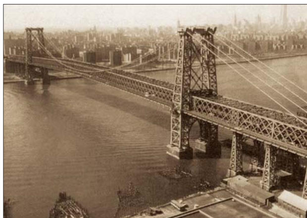
31. kép: A New York-i Williamsburg kábelhíd túlméretezett rácsos, szekrényes kialakítású merevítőtartójával és kedvezőtlen megjelenésű pilonjaival inkább vasszörny, mint szép híd benyomását kelti (1903)
