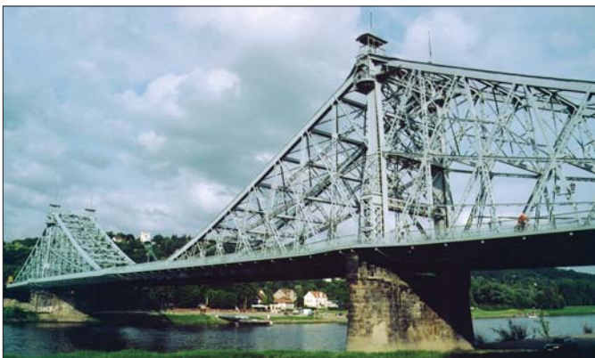
43. kép: Az Elbát Drezda előtt áthidaló Blaues Wunder (kék csoda) nevű híd nem sokkal előbb épült (1890) mint a Ferencz József híd. Noha szerkezeti rendszere elvben hasonló, vonalvezetésében csúnya törések vannak, rácsozata kaotikus, emiatt szépnak nem nevezhető
