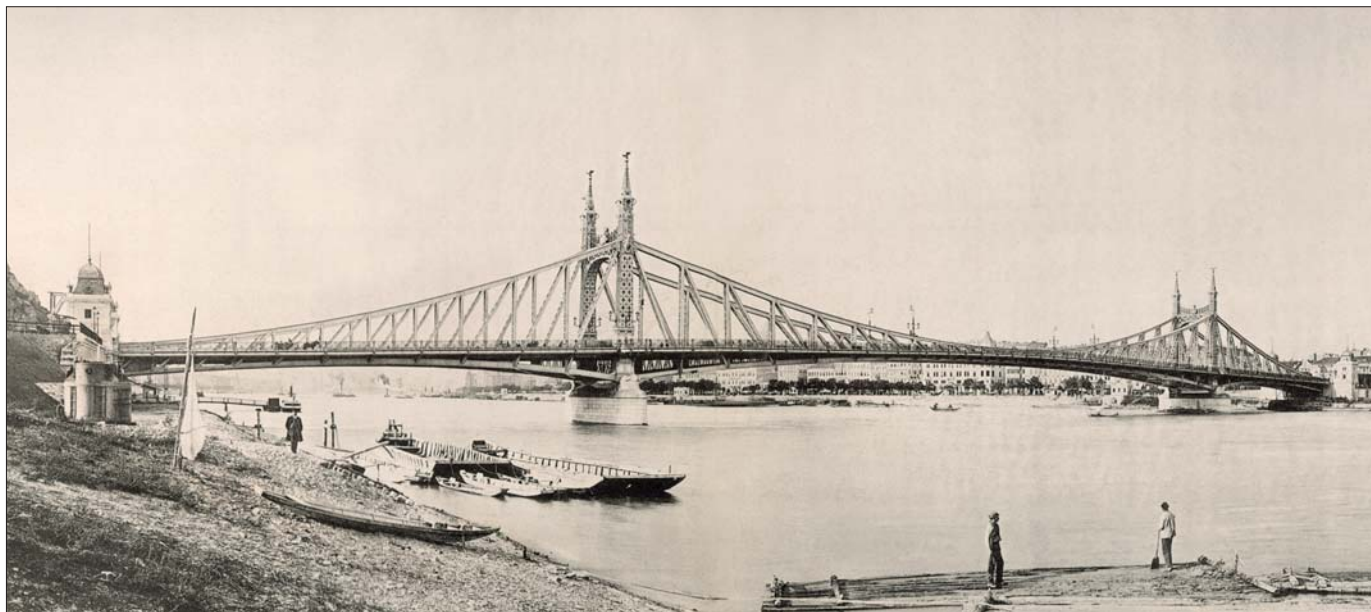
38. kép: Budapest harmadik közúti hídjának vonalvezetése, a nyílasközép töretlensége és karcúsága inkább a függőhidakra, mint a befüggesztett tartós konzolos (Gerber-csuklós) hidakra emlékeztet
